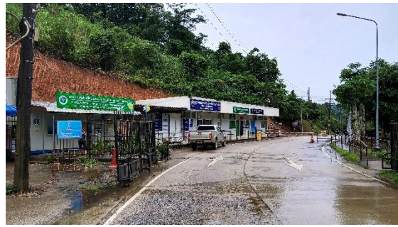
บริเวณอาคารด่านพรมแดนถาวรบ้านฮวก กม.1+770 ขวาทาง
