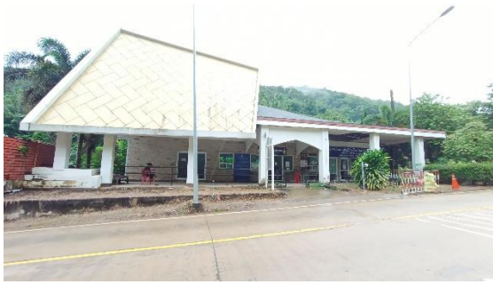
บริเวณอาคารด่านพรมแดนถาวรบ้านฮวก กม.1+770 ซ้ายทาง
