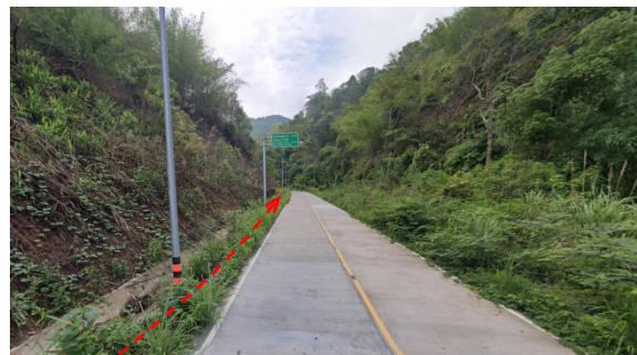
ตัวอย่างสภาพรางระบายน้ำข้างทาง
